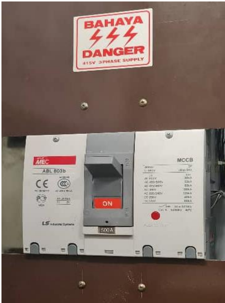
MCCB LZ di bilik kawalan motor lif pada kadar 500A
