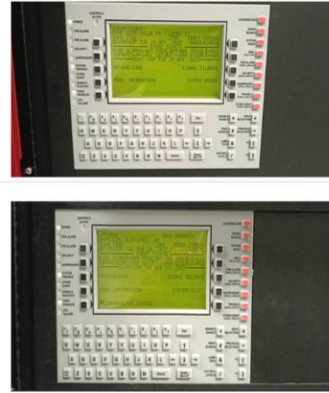
Fire alarm panel (Notifier) di Aras 18 Fire alarm panel (Notifier) di Aras GF di BCS Fire alarm panel (Notifier) di Aras 38
