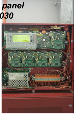
Fire alarm panel (Notifier) di Aras 18 Fire alarm panel (Notifier) di Aras GF di BCS Fire alarm panel (Notifier) di Aras 38
