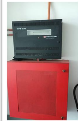
Fire alarm panel (Notifier) di Aras 18 Fire alarm panel (Notifier) di Aras GF di BCS Fire alarm panel (Notifier) di Aras 38
