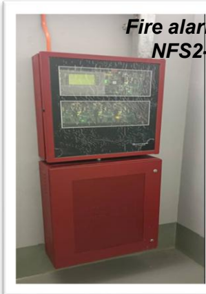
Fire alarm panel (Notifier) di Aras 18 Fire alarm panel (Notifier) di Aras GF di BCS Fire alarm panel (Notifier) di Aras 38
