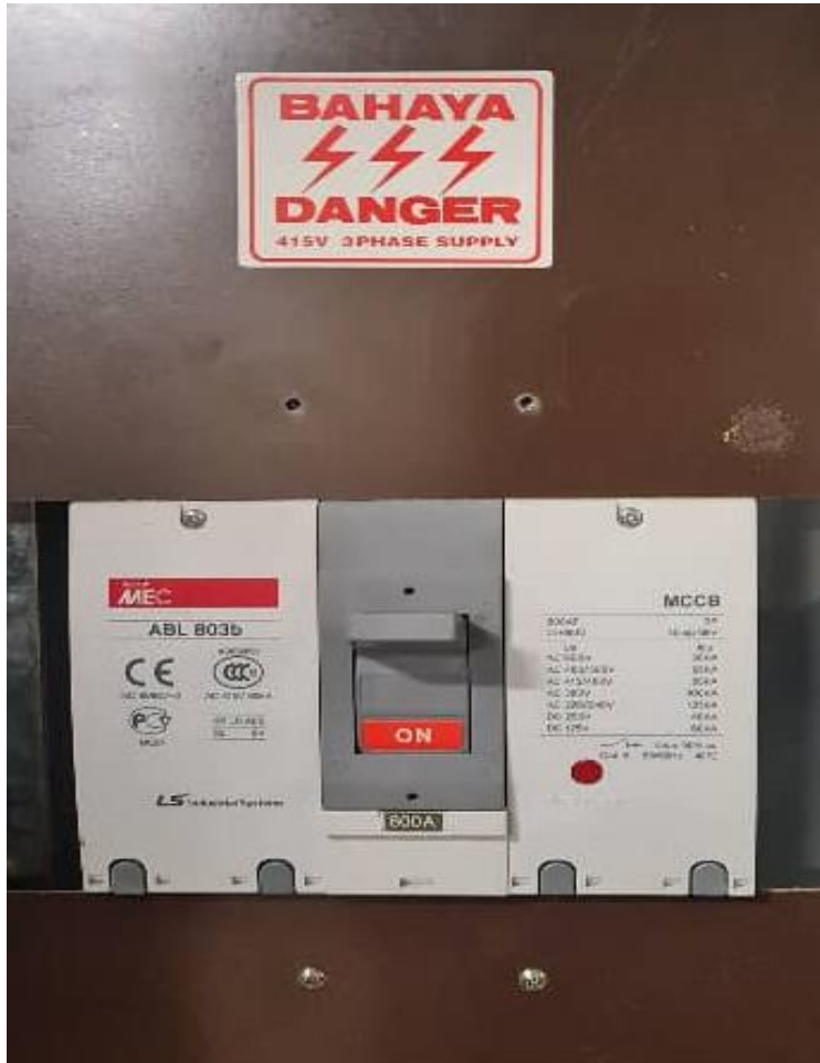
MCCB HZ di bilik kawalan motor lif pada kadar 800A
