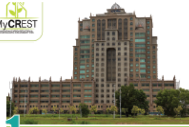
1 Bangunan Pejabat Kerajaan Kementerian Pelancongan & Kebudayaan Malaysia
